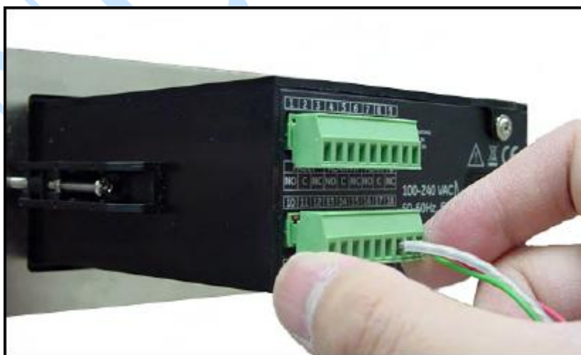
图 25 电缆的接线端连接
