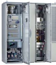
ATV61, ATV71 柜式变频器 ● 90 至 2400 kW
